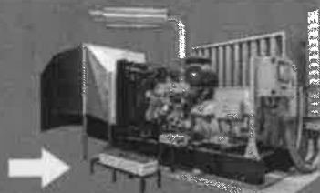
การติดตั้งตัวดูดซับแรงสั่นสะเทือน ที่ทำให้เกิดเสียงดัง/วัสดุดูดซับแรงสั่นสะเทือน To install a vibration absorber / vibration damping material
